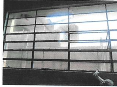
Foto 2: Módulo 2: Remozamiento de ventanas y sustitución de vidrios.
