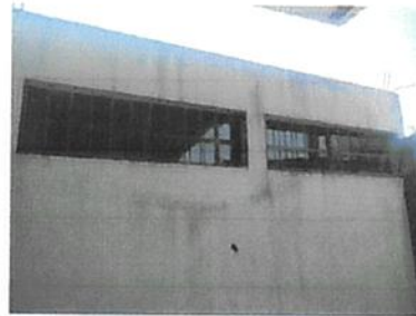
Foto 4: Módulo 4: Sustitución de vidrio en ventanas de baño.
