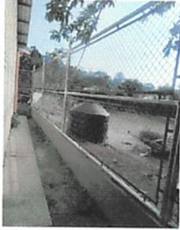
Foto 1: Módulo 1: Sustitución de muro perimetral existente por muro de mampostería y malla compuesta por cemento corrido y tres hiladas de block.
