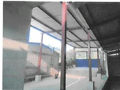
Foto 6: Módulo 6: Sustitución de estructura de soporte de metal por tubo cuadrado, lamina troqueleada, elementos de fijación y fabricación de bases de concreto.
