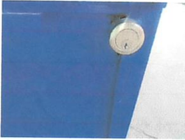
Foto 3: Módulo 3: Sustitución de chapas en puertas de aulas y cocina.
